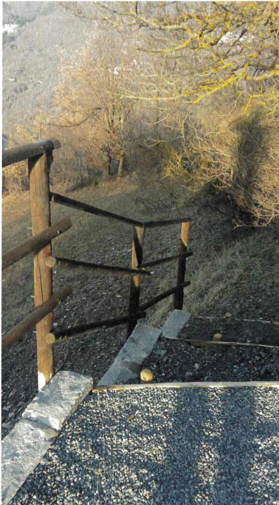
Parte terminale parapetto da sostituire con ringhiera in profilati zincati
