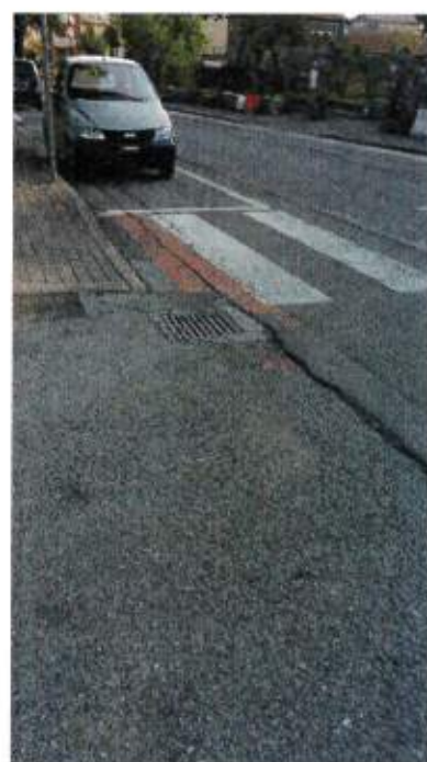
POZZETTO E CADITOIA da sostituire con pozzetto e caditoia dim 60x60
