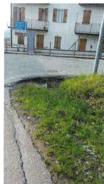
POZZETTO CON CADITOIA da sostituire con pozzetto in C.A.V. dim 100x100 con gaveta
